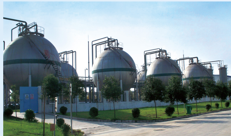
氢气站—中硅高科多晶硅扩建项目
