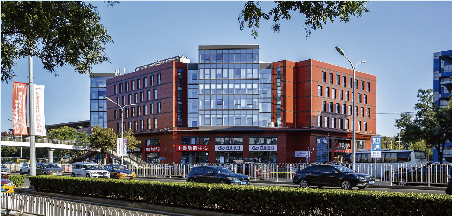
北京东城区珠市口东大街2号改造项目
