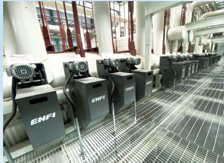
湖北襄阳垃圾焚烧项目弹簧振打设计+供货
