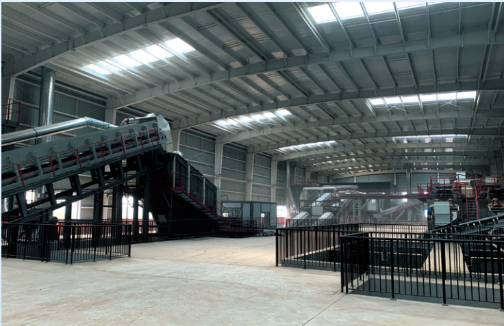
容东片区再生建材场项目
