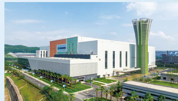
成都万兴环保发电厂(二期)项目
