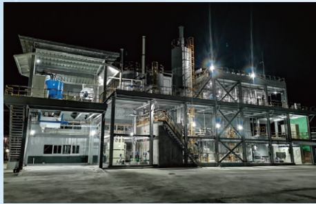
陕煤研究院氧化石墨烯污水处理工程
