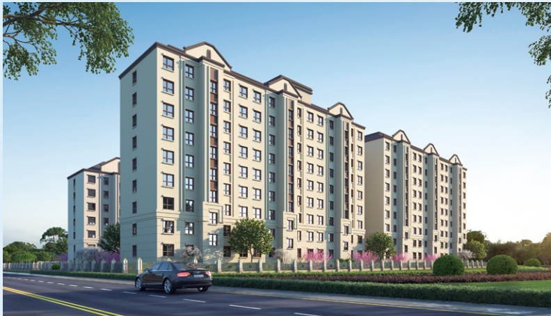
富蕴县有色镍锦铜城小区建设项目
