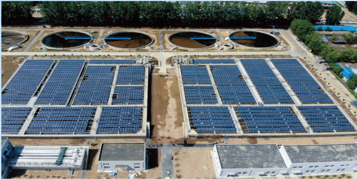
北京良乡污水厂分布式光伏电站
