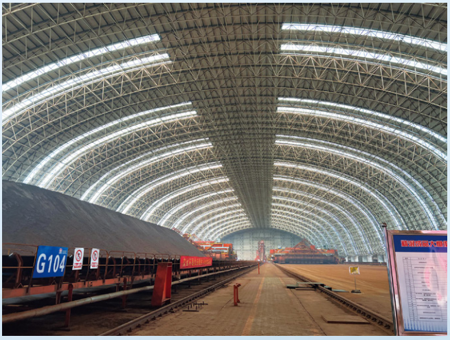
曹妃甸国际矿石交易中心项目
