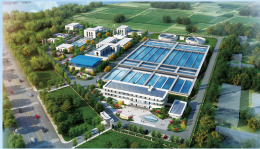
青州市东南部污水厂建设工程
