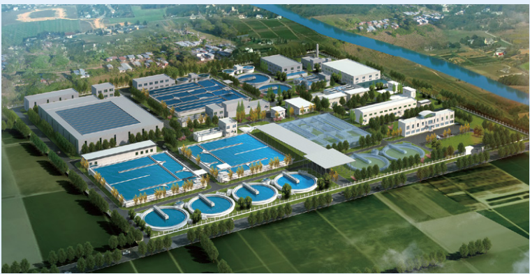
北京市房山区良乡污水处理厂二期工程
