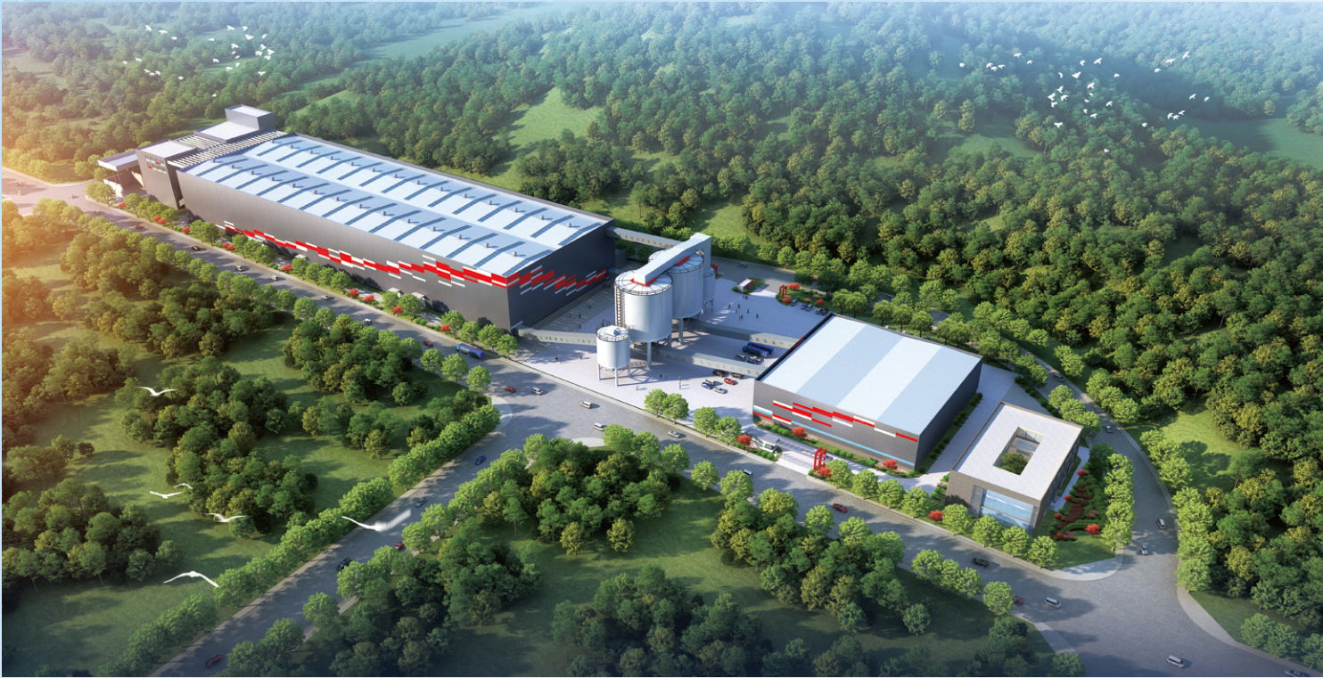
马钢矿业资源综合利用新型材料科普基地EPC总承包项目
