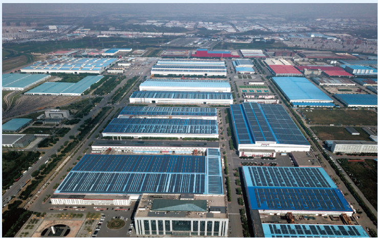
北方重工30MWp屋顶分布式光伏电站
