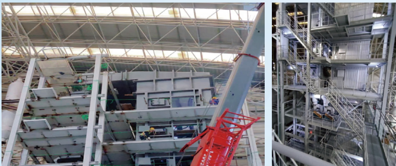
成都隆丰环保发电厂氮氧化物治理提标改造项目(脱酸脱硝改造EPC)
