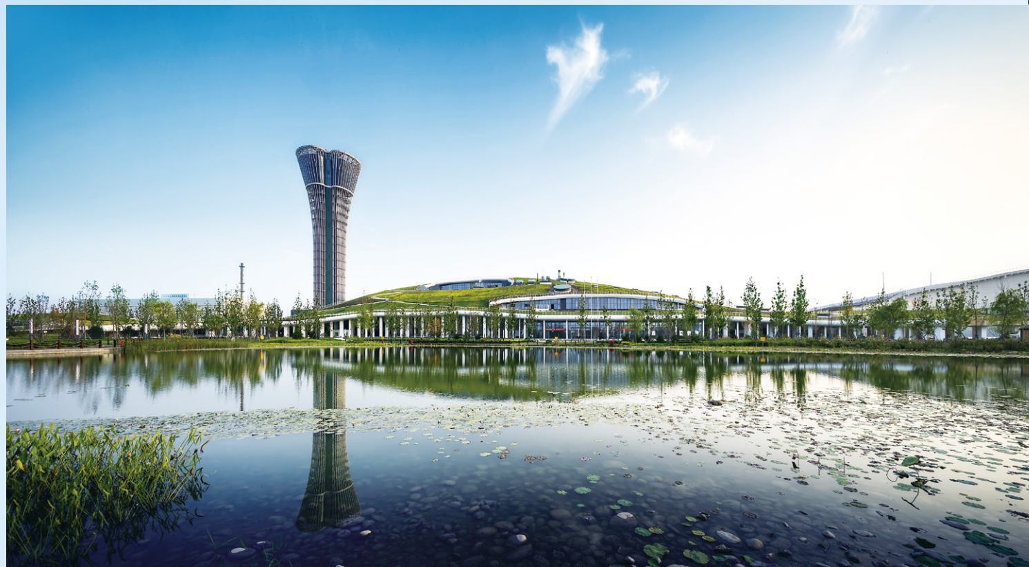
雄安新区垃圾综合处理设施项目
