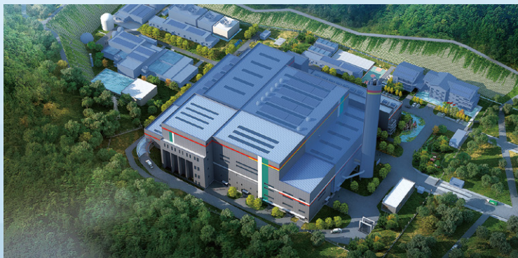
襄阳恩非生活垃圾焚烧厂渗沥液处理站工程
