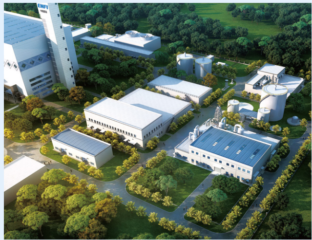
固安县有机垃圾资源化处置项目
