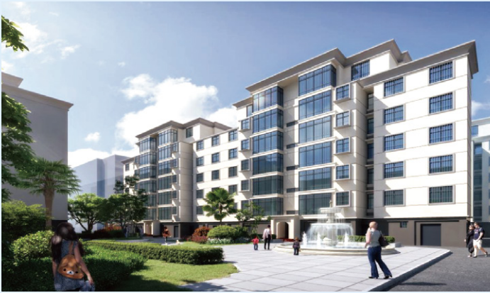
定南县2023年城区老旧小区改造项目
