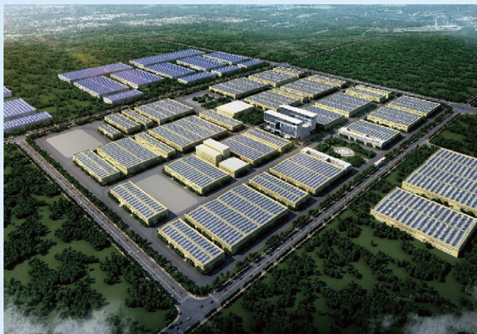
沈阳机床集团36MWp屋顶光伏电站
