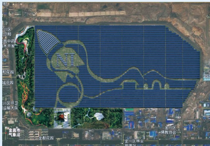
金川集团1#尾矿库生态修复及150MWp光伏电站
