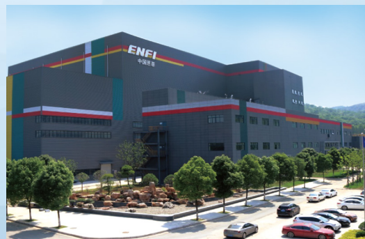
襄阳生活垃圾焚烧发电厂项目
