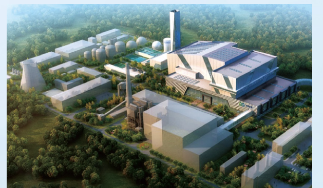
临沂市生活垃圾、污泥焚烧发电厂项目
