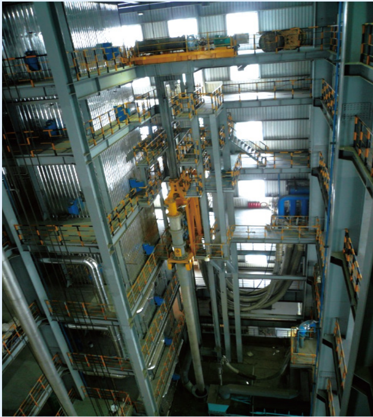
金川集团有限公司富氧顶吹镍熔炼—大型三通式余热锅炉工程总承包项目
