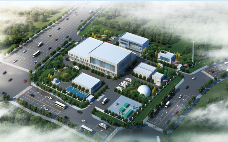
平潭综合实验区餐厨垃圾处理厂项目
