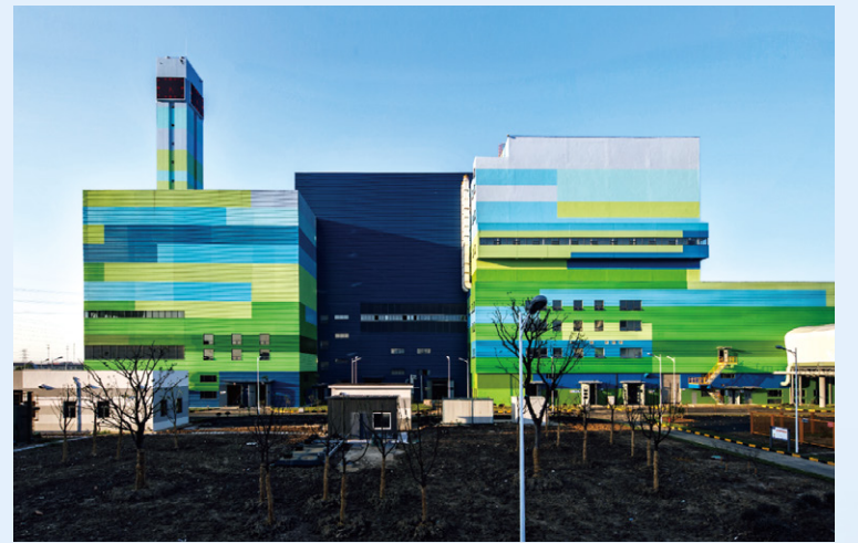
无锡市锡东生活垃圾焚烧发电厂项目
