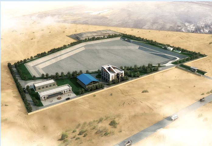
金昌市危险废物资源化处置项目
