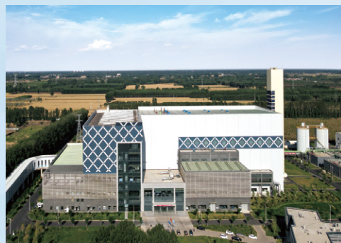
固安县生活垃圾焚烧发电厂项目
