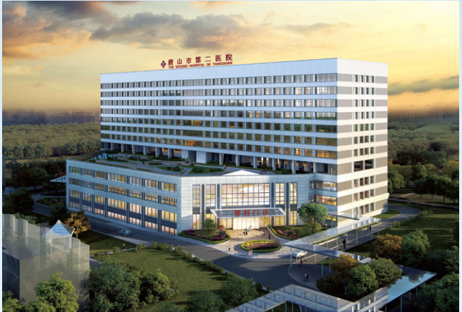
唐山市第二医院新建骨科大楼项目
