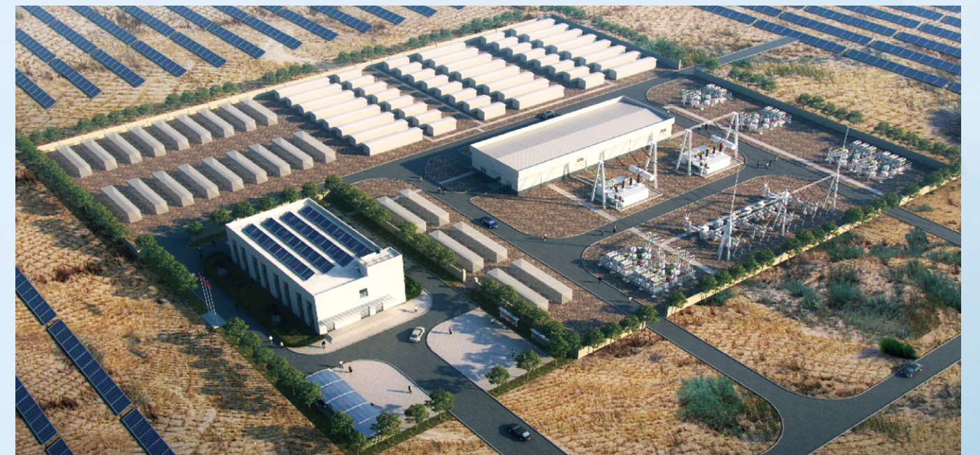
金川集团东大滩300MWp光伏电站
