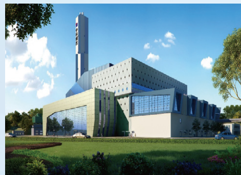
绵阳市生活垃圾焚烧发电厂项目
