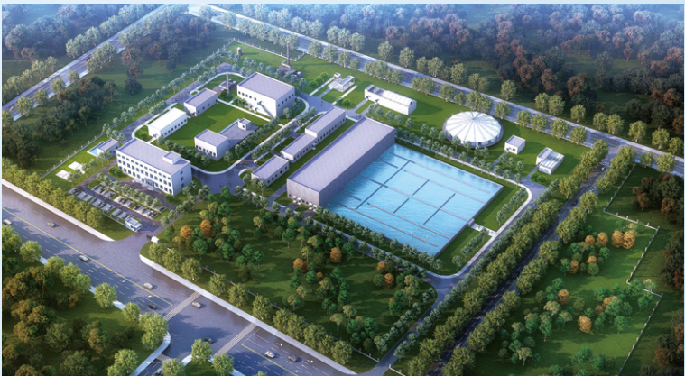
石家庄藁城区南部城区新建污水处理厂及附属基础设施建设工程
