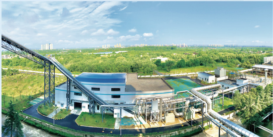
合肥市污泥干化协同焚烧项目
