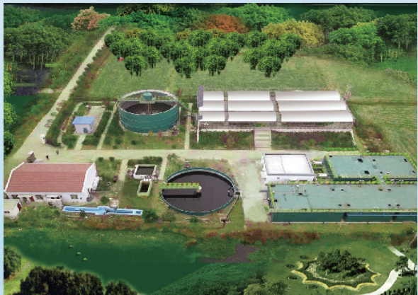
安陆市乡镇生活污水治理工程
