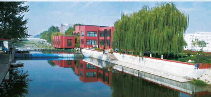
污水处理厂及配套管网项目
