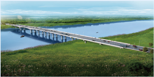
安陆市府河三桥建设项目
