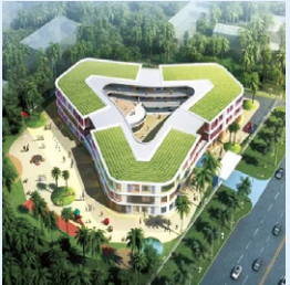
海口高坡幼儿园项目
