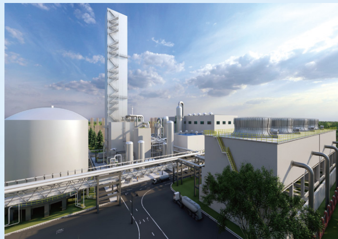
氧气站—广西金川空分项目
