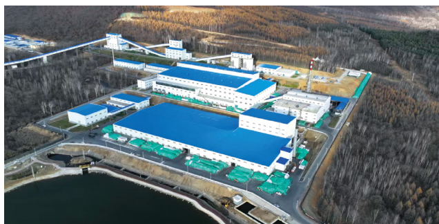
全球单体最大的石墨矿选矿生产线——云山石墨选矿厂（EPC）
