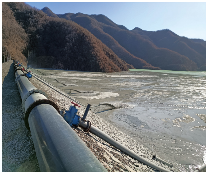
东沟钼矿北沟尾矿库 总库容1.24亿 \text{m}^3 ，总坝高195m
