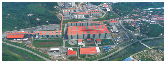
在产千万吨级深井超大型铁矿——思山岭铁矿
